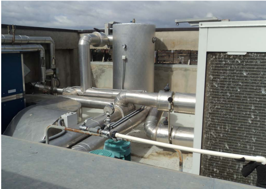
Ilustración 6: Enfriadora TRANE da servicio a la ampliación
