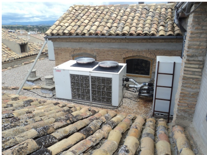
Ilustración 7: Enfriadora LENNOX da servicio a algunos despachos de la parte antigua
